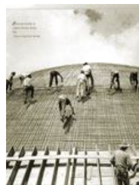
Figura 4 – Construção do prédio do Congresso Nacional. Brasília (1958)
