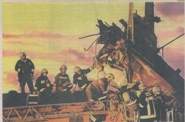
BRATISLAVA Bombeiros trabalham nos destroços de acidente provocado por choque entre dois trens na cidade de Welgelsdorf, cerca de 30 km ao sul de Viena, na Áustria, que deixou pelo menos cinco pessoas mortas e fez aproximadamente 30 feridos
