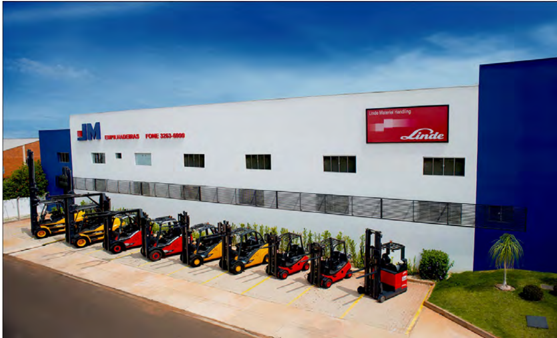
Figura 1 – Centro de Assistência Técnica JM Empilhadeiras Fonte: arquivo JM Empilhadeiras
